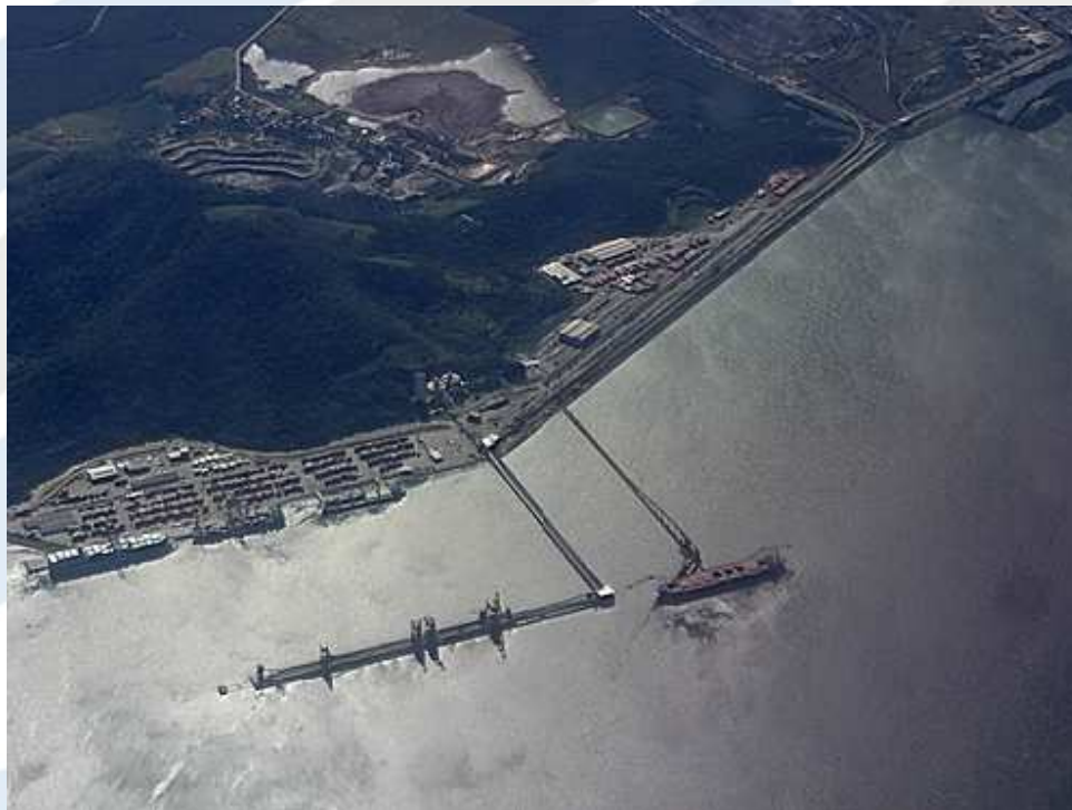
Figura 10 - Vista parcial do Porto de Itaguaí.
