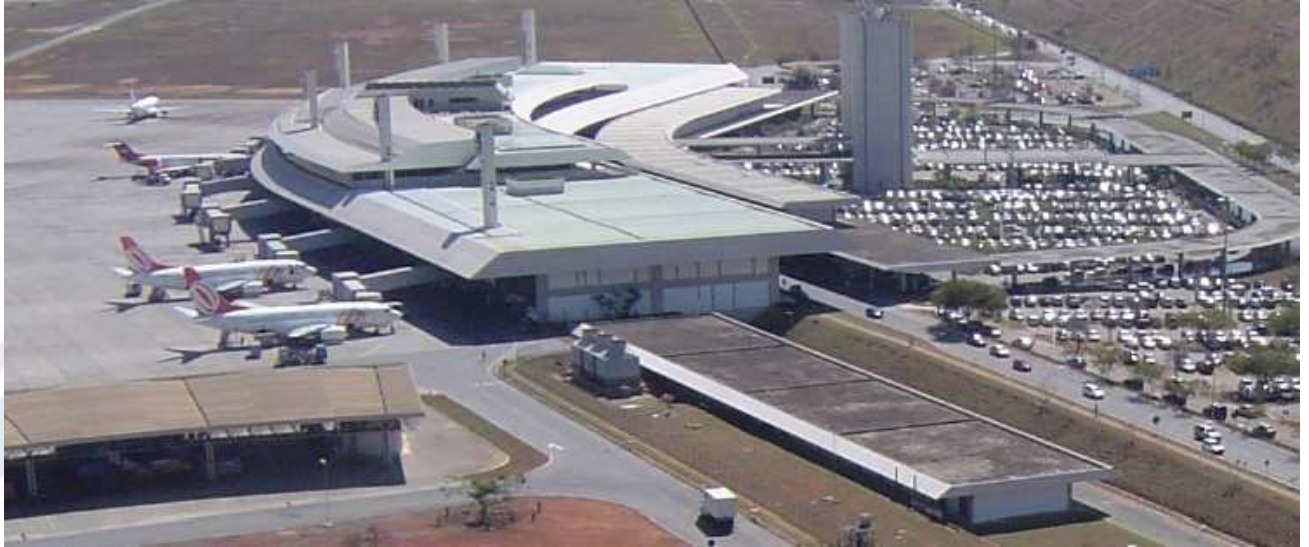
Figura 6 - Vista parcial do Aeroporto Internacional Tancredo Neves
